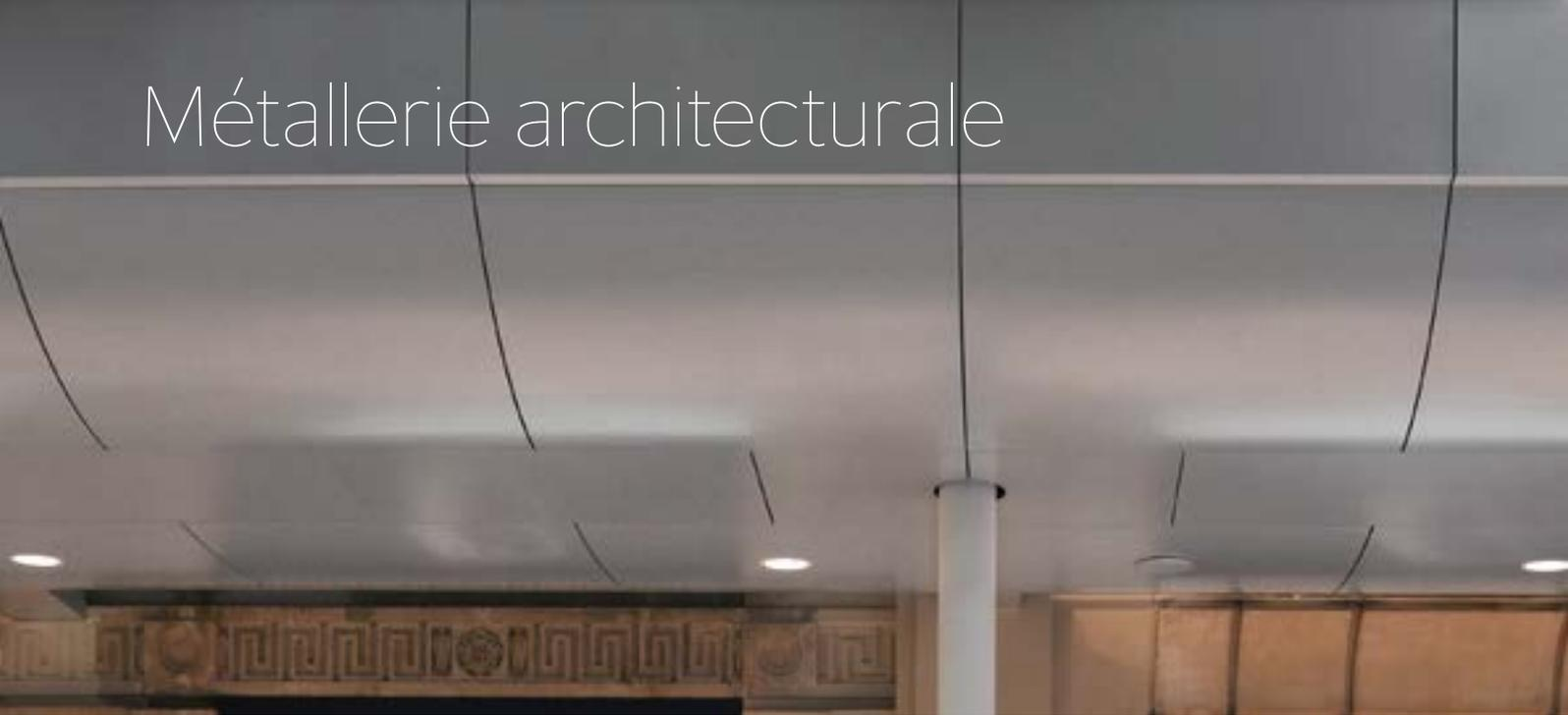
Les systèmes de plafond métalliques nécessitent souvent une transition étudiée entre les plans horizontaux et verticaux. La métallerie architecturale crée cette intégration entre les plans sans dénaturer l'idée de conception d'origine. À titre d'exemple, les cloisons, les habillages de colonnes comme les panneaux muraux peuvent fournir des solutions conceptuelles impactant les exigences d'intégration du plafond.
