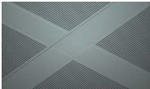
La trame écossaise peut utiliser des croisillons et entretoises suspendus par des tiges filetées et suspentes. Ce détail peut être répliqué en pressant les détails de croisement factice dans le profilé C. Le recours aux profilés C au lieu des croisillons permet d'obtenir une structure bien plus rigide et durable. Les profilés C assurent également la flexibilité nécessaire pour éviter les ossature autour des gaines dans le plénum.
